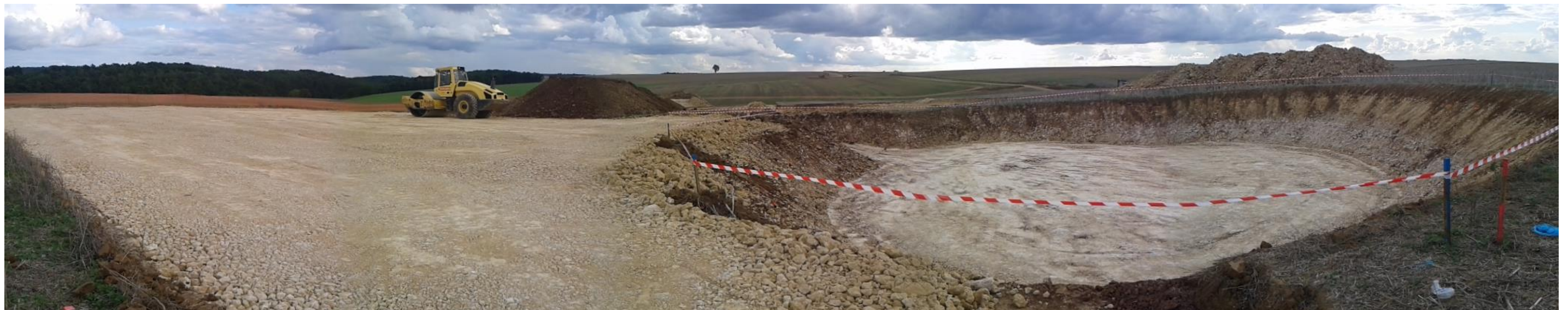
Photo 7 Aire de montage Source : BORALEX
