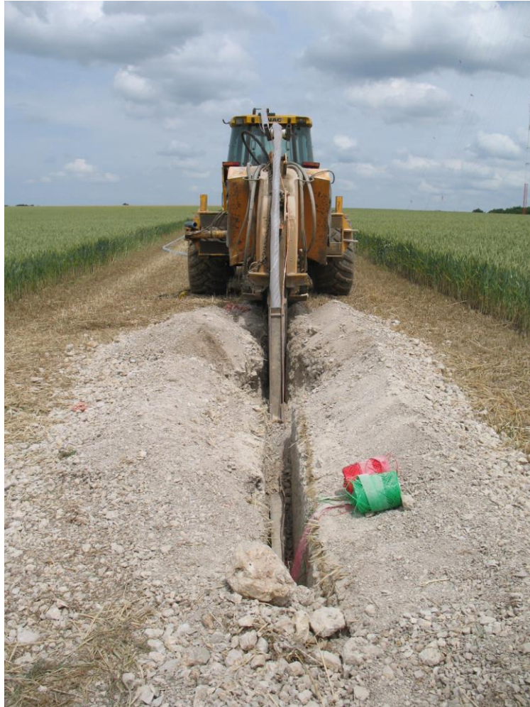
Photo 8 Tranchées pour le passage des câbles électriques
