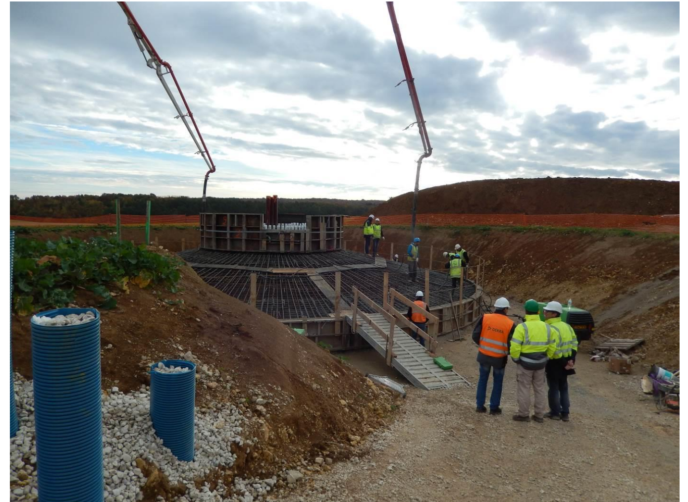
Photos 6 Ferrailage d'une fondation et système d'ancrage des mâts
