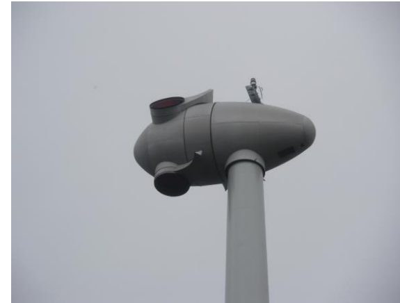
Photo 10 Montage du rotor et des pales
